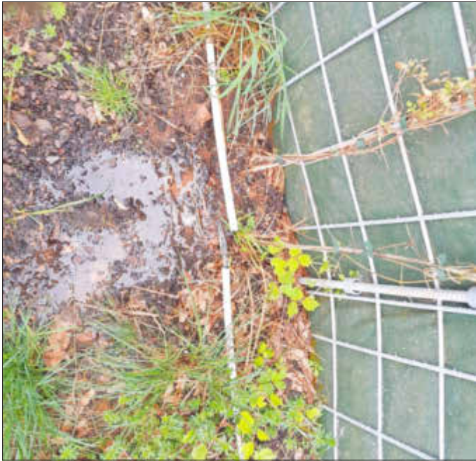
Der Bewässerungsschlauch an der Lärmschutzwand beim Neubaugebiet Haselbachäcker wurde an acht separaten Stellen am 03. Mai 2024 vorsätzlich durchtrennt. Darüber hinaus wurde ein Loch in das Flies geschnitten um auf die Wand klettern zu können. Foto: Florian Nagler
